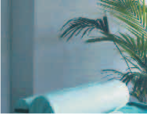
Lehmputz eingefärbt mit Lascaux Resonance Gouache, mehrschichtig aufgetragen. Farbgestaltung: Vincent Jud Gesundheitszentrum Gündisau (CH)
